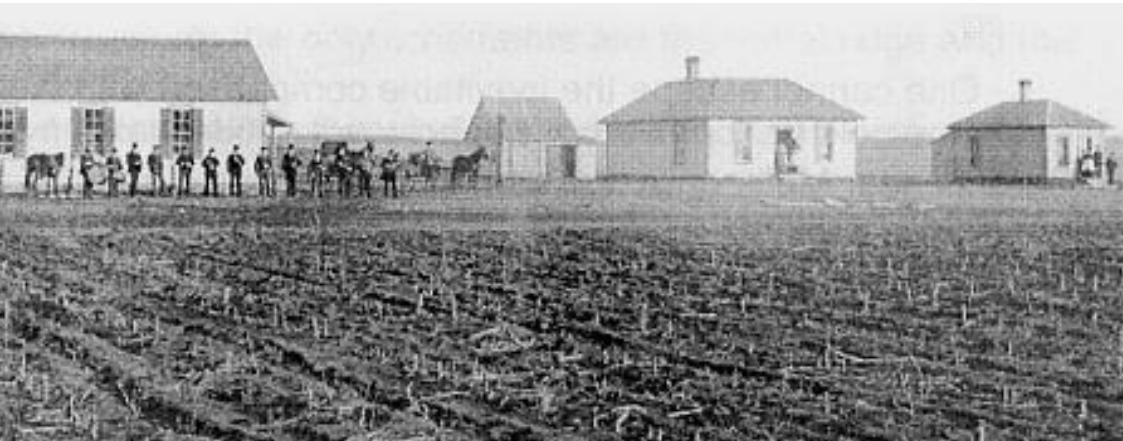
v.l.n.r. Gemeindehaus Tempelfeld, Schulhaus, Haus des Gemeinde-Ältesten
